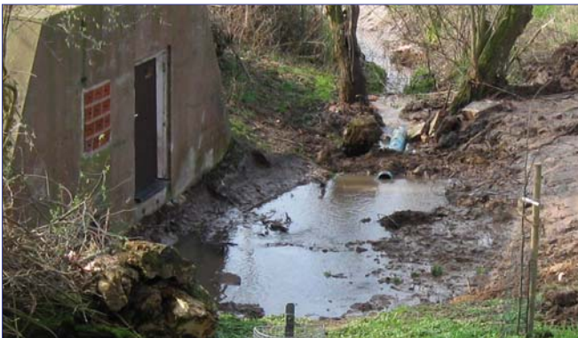
Die Quellfassungen sind entfernt
