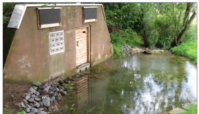
Das neue Fledermausquartier im alten Pumpenhaus, davor der Quelltümpel
